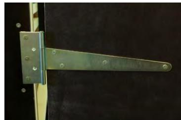
Fixez une Planche 19 de chaque côté de la Planche 21 de l'aide d'une charnière d'un côté et un mécanisme de verrouillage de l'autre côté pour permettre à la porte pour ouvrir et fermer.
