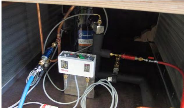
Allumez le ventilateur et commencez à ajouter du réfrigérant au raccord sur le compresseur basse pression.
