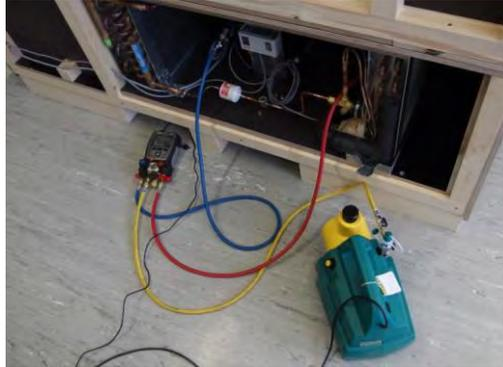
Re-fixez la pompe à vide et créez un vide dans le système pour éliminer l'humidité.
